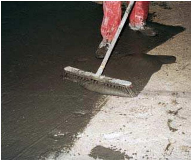
Материал PCI Repahaft посредством щётки наносится на основание. Непосредственно после этого свежий раствор для пола наносится на свежий адгезионный слой.
